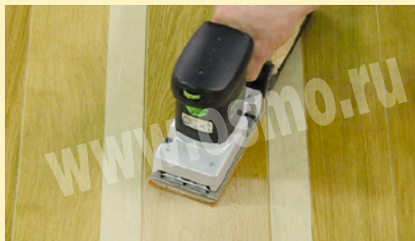
Тщательно отшлифуйте поврежденную поверхность.
