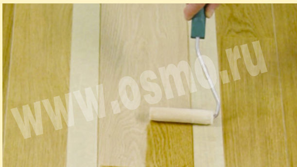
Нанесите тонкий равномерный слой Osmo-масла с твердым воском Hartwachs-Öl с помощью валика из микрофибры.
